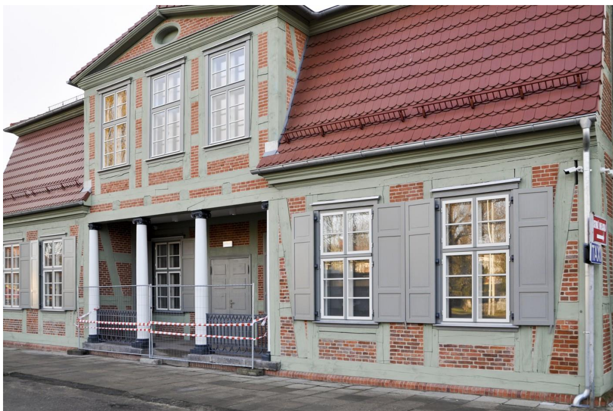
Budynek przy ul. Krótkiej 6 (po remoncie)
