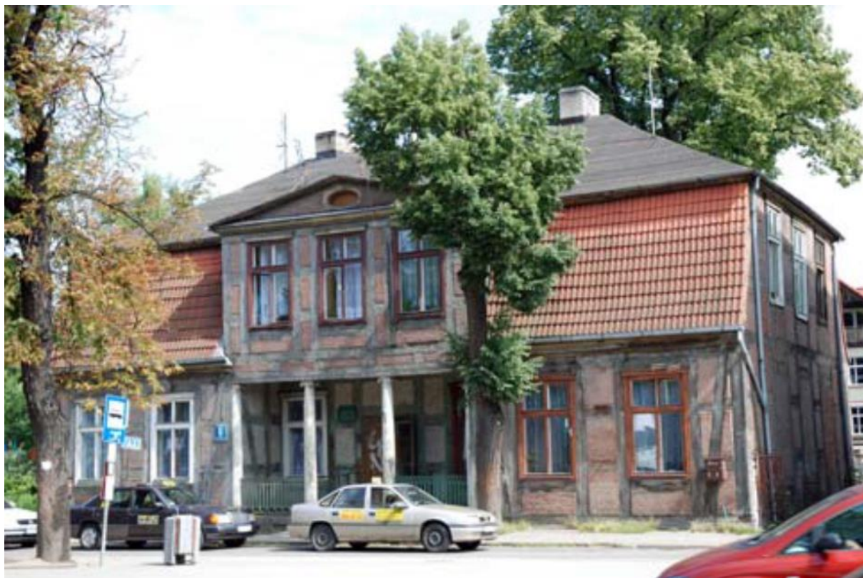
Budynek przy ul. Krótkiej 6 (przed remontem) 2009 r.
