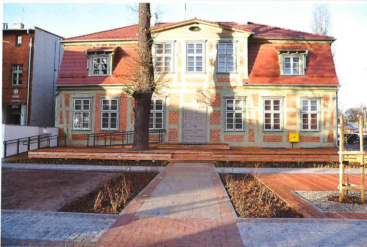
Budynek przy ul. Krótkiej 6 z otoczeniem od strony wschodniej
