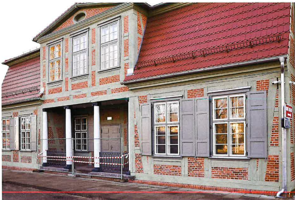
Budynek przy ul. Krótkiej 6 od strony ul. Krótkiej
