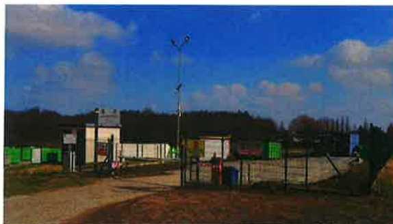
GPSZOK ul. Kupiecka fot. 1 wjazd
