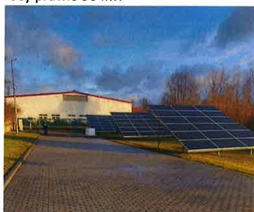
Panele fotowoltaiczne na dachu budynku SUW nr 1; Panele fotowoltaiczne posadowione na gruncie przy studniach K3 i K5
