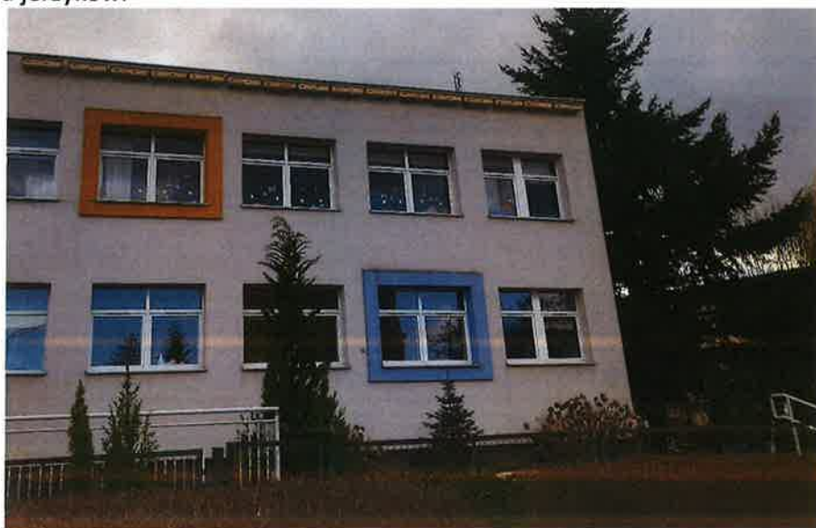
Budki dla jerzyków zamontowane na budynku Przedszkola ul. Żwirki i Wigury
