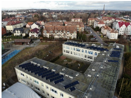
Panele fotowoltaiczne zamontowane na dachu budynku SP Nr 3 ul. Matejki 1
