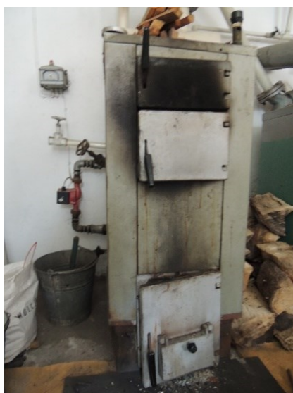
Piec przed modernizacją
