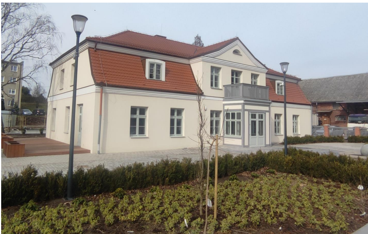
Budynek przy ul. Wojska Polskiego 44 od strony południowej.
